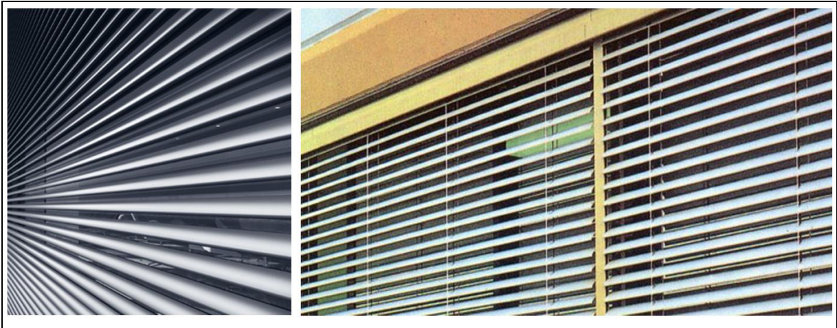
Intervento di apposizione delle schermature esterne per il controllo dell'irraggiamento solare
